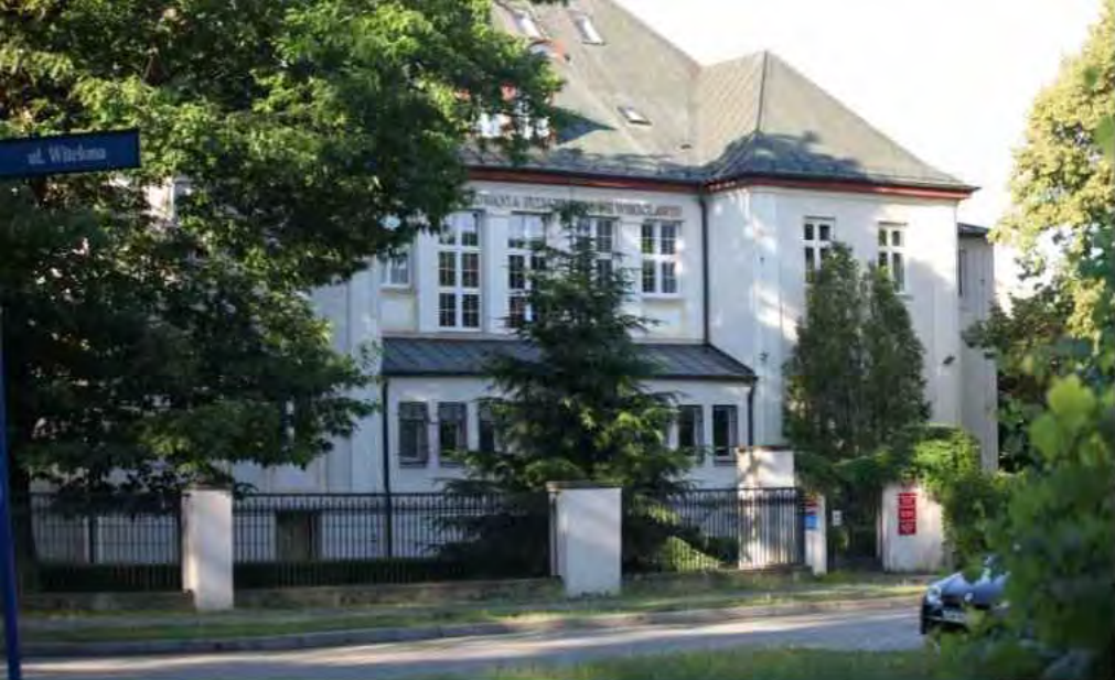
Budynek przy ul. Witelona 25
