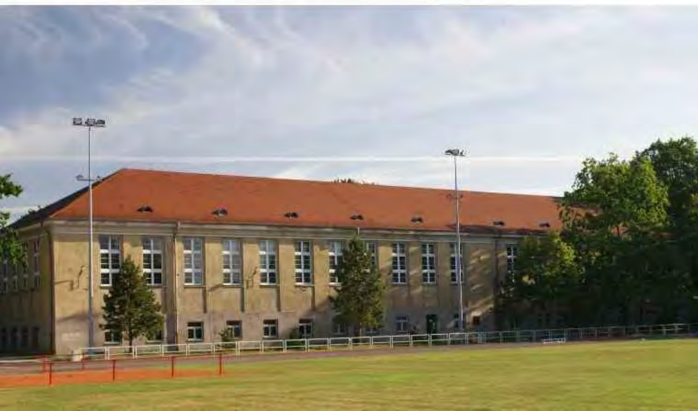
Budynek przy ul. Witelona 25a
